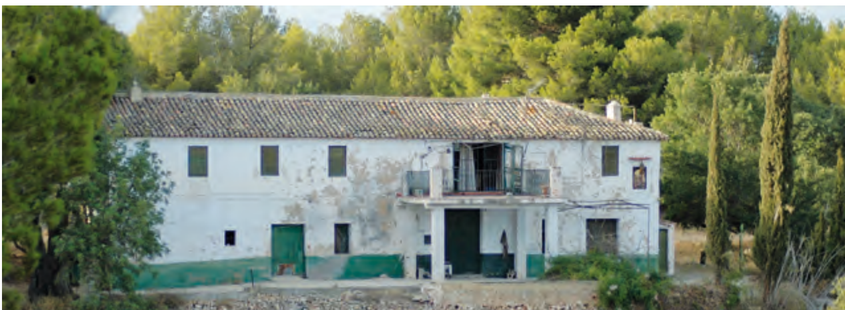
Estado actual de la casa de la finca San Pere. ©Nina F. 2012.
